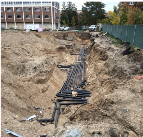
Geothermal drilling on the Mini Bald Spot (Fall 2017)
